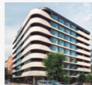
Varna Wave (bâtiment résidentiel) Varna, Bulgarie Aquarea et Aquarea Smart Cloud
