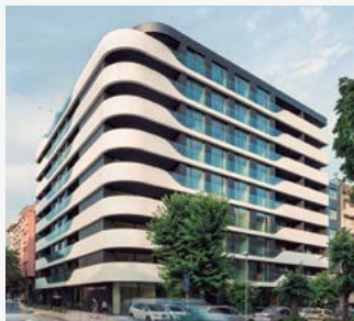
Varna Wave (bâtiment résidentiel) Varna, Bulgarie Aquarea et Aquarea Smart Cloud
