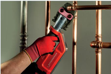
3 points de sertissage, un de chaque côté du bourrelet et un point de sertissage comprimant le joint torique
